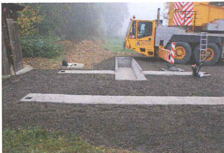
Streifenfundament
