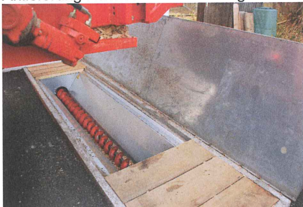
Anlieferung Hackschnitzel/ Fülltrogt
